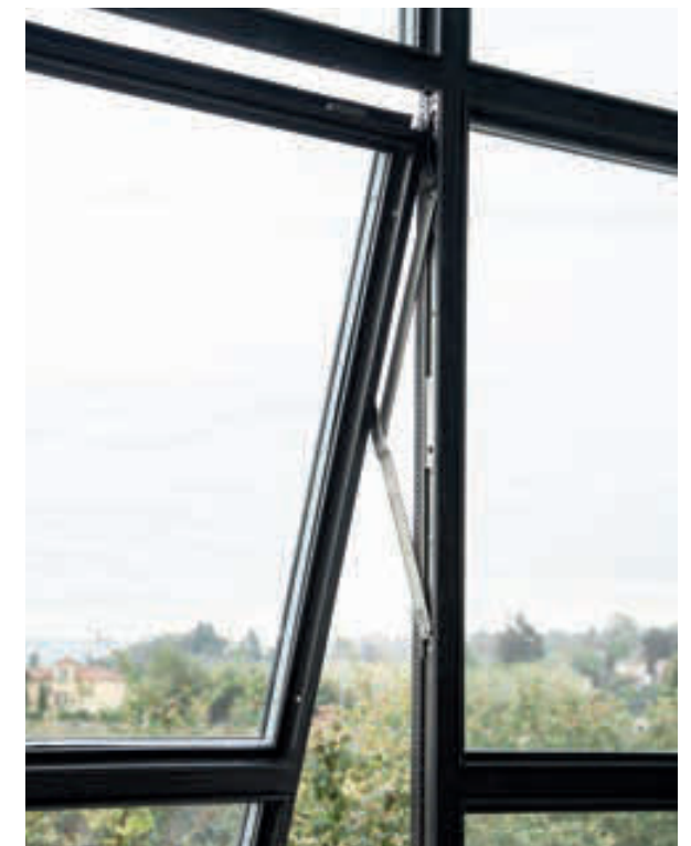
dettaglio apertura a sporgere con accessori Jansen Janisol Arte 2.0 di altissima qualità
