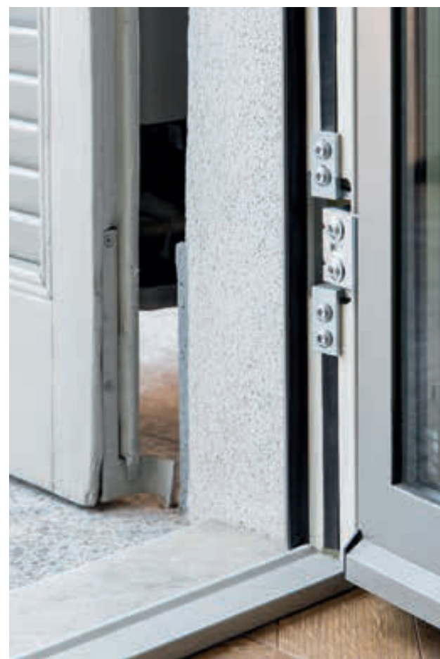
dettaglio cerniera a scomparsa.
